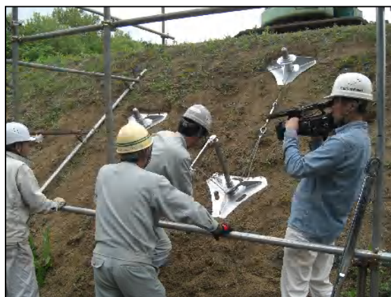
新タイプ支圧板設置試験の撮影状況
