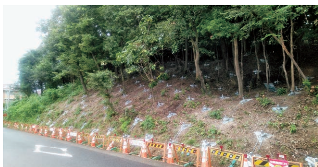
施工直後全景
