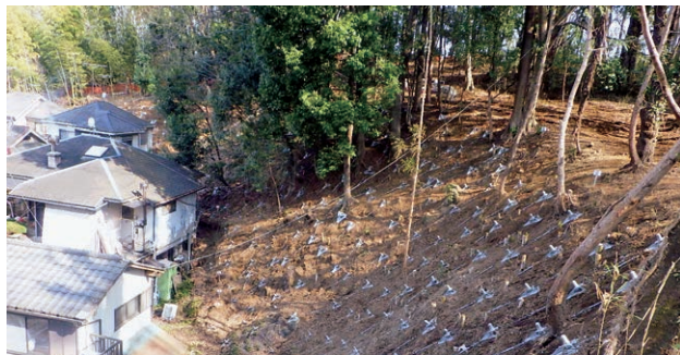
施工直後全景
