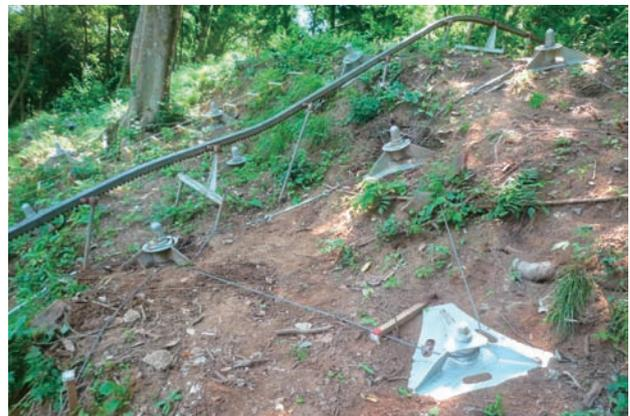
手前に新支圧板が施工されています(キャップ取付前)。奥は従来タイプの支圧板(前年度施工)
