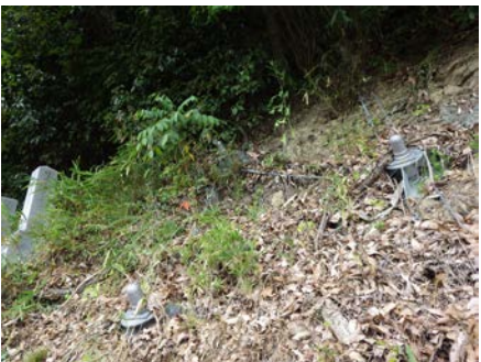
No.4 三原市沼田 (上: 全景、下: 斜面状況)
